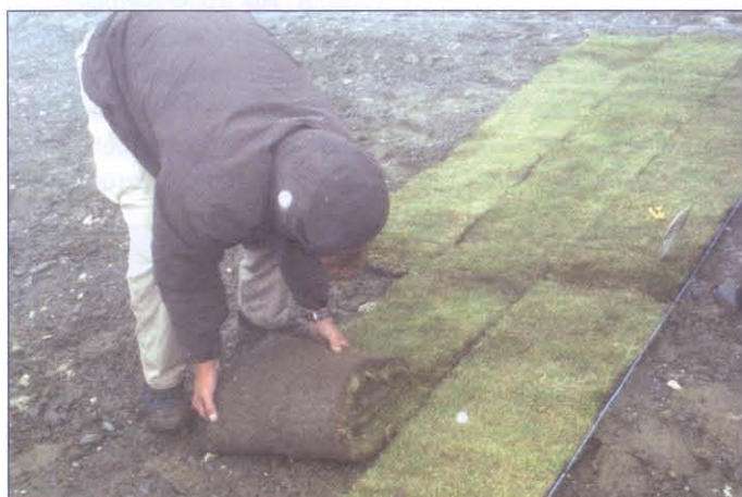
Verlegung von Alpinem Fertiggras
