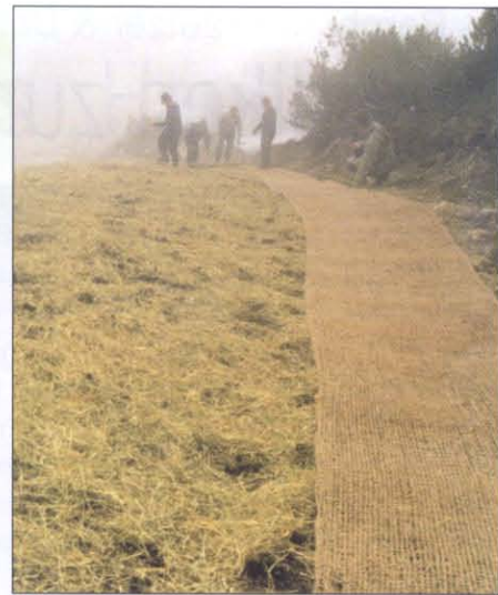
Mulchsaaten in Kombination mit Geonetzen bieten hervorragenden Erosions-Schutz
