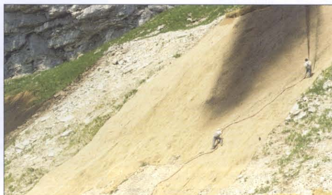
Hydrosaat - bei dieser Methode werden Samen, Dünger, Klebemittel, Bodenhilfs-Stoffe und manchmal auch Mulchstoffe mit Wasser vermischt und auf die zu begrünenden Flächen verteilt
