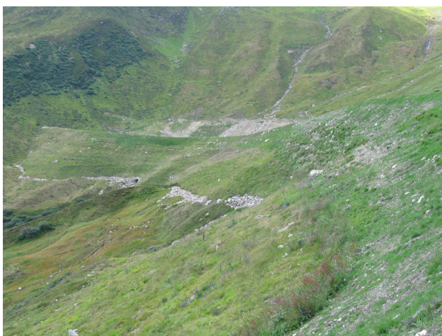
Abbildung 3: Talseitige Böschung des Lawinendamms, großteils begrünt mit Soden aus dem Fassungsbereich
