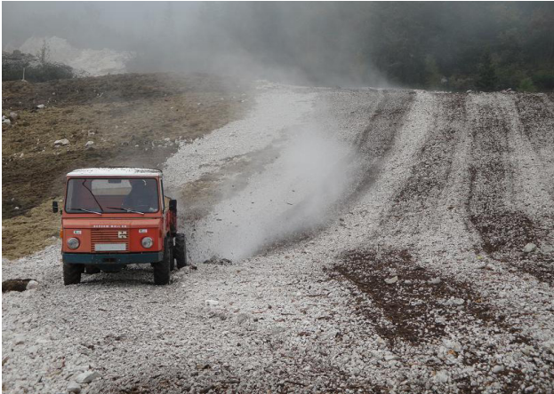
Abbildung 6: Aufbringen des Häckselguts
