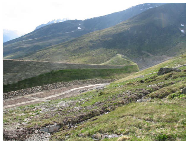
Abbildung 4: Mischungversuch und bergseitige Böschung aus bewehrter Erde, begrünt mit Spritzbegrünung
