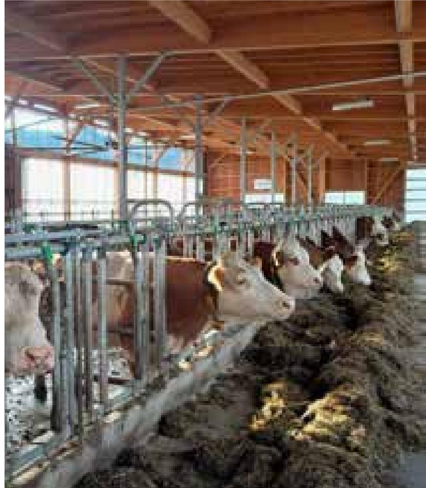
Eine Pulldachkonstruktion aus Holz reduziert die Hitzebelastung im Bestand
