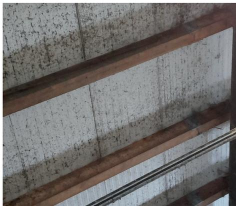
Abbildung 1: Verfärbungen an der Dachunterseite weisen auf fehlerhafte Luftzirkulation hin
