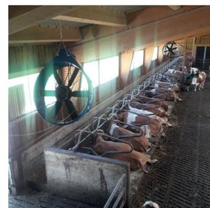
Abbildung 4: Kühlung einer Liegeboxenreihe mittels Ventilatoren
