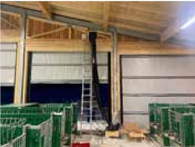
Abbildung 4: Montage der vet.smart.tubes im Bereich der Kälberboxen (Quelle: Neumayer, 2022)
