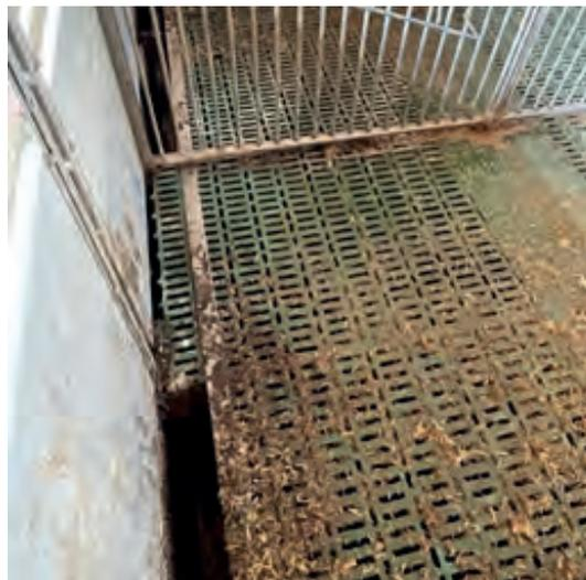
Abbildung 9: Permanenter Verschluss des Kotschlitzes durch 75 cm langes Kunststoffrost-Element im Tränkebereich
