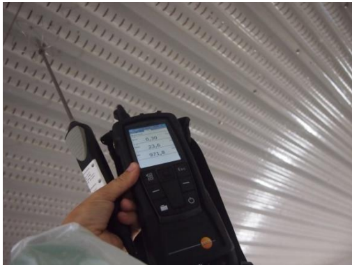
Abbildung 1: Überprüfung einer Zuluftdecke
