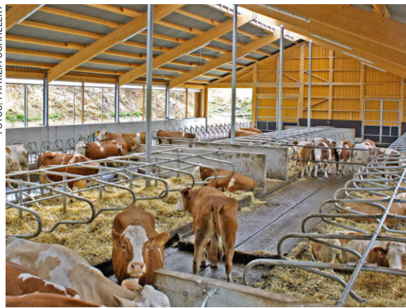
Ein Mistgang mit einem Quergefälle und einer Harnsammelrinne kann die Ammoniak-Emission in Viehställen deutlich verringern.
