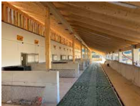
Abbildung 6: Auslauf mit Fress- bzw. Aktivitäts- und Mistbereich (Quelle: Raumberg-Gumpenstein)
