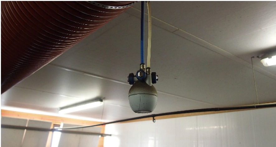
Abb. 4b: Sprühkopf eines Zweistoffdüsensystems (HBLFA, 2020)
