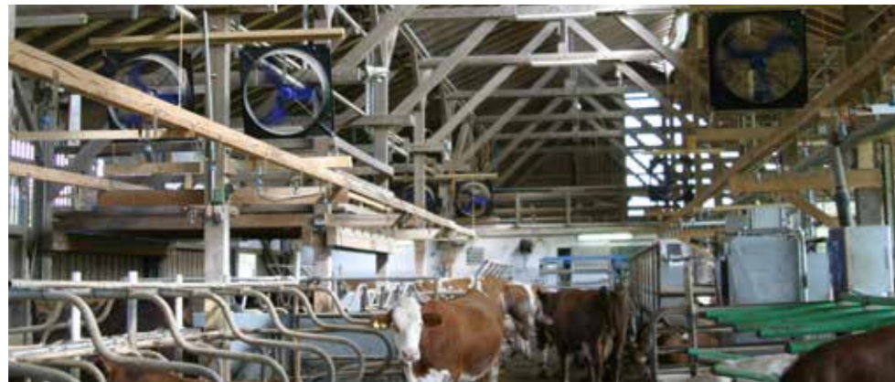
Ventilatorenanordnung im Milchviehstall (LfL Bayern)
