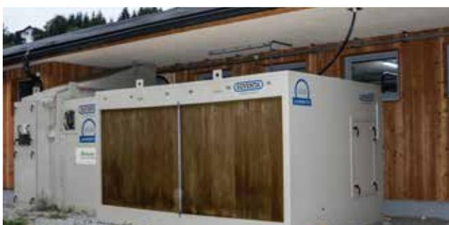
Kombinierte Abluftreinigungsanlage (Chemowäscher plus Biofilter)
