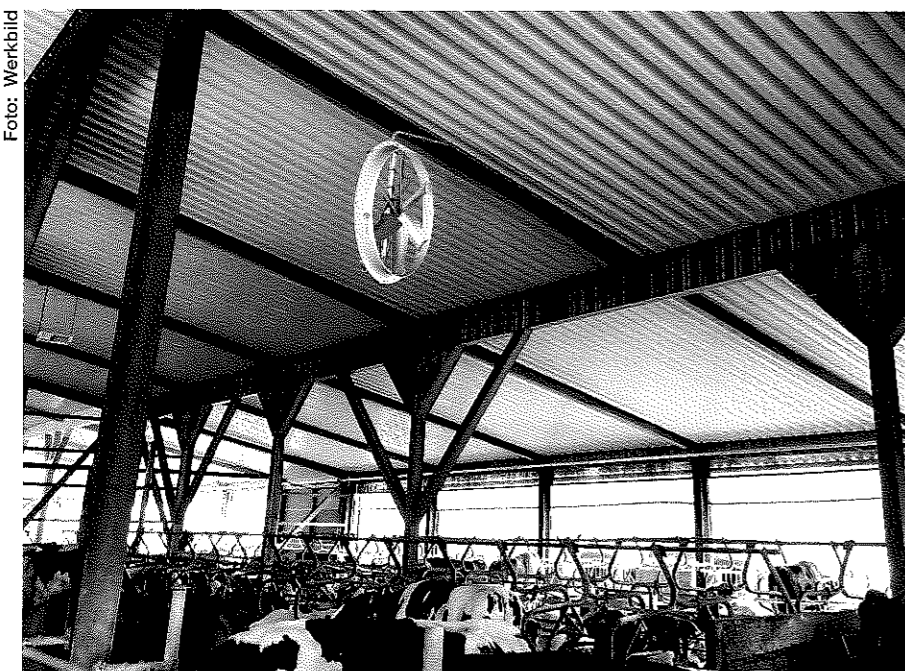
Die Ventilatoren wurden auf einem Holzgerüst mit 2,7 m Unterkantenhöhe über dem Boden aufgehängt.
