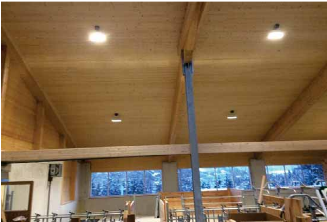
Dachkonstruktion – Salzburg Nov. 2016
