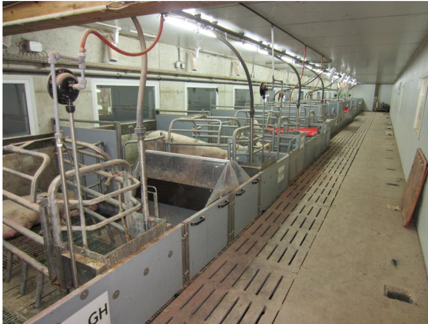
Abbildung 9: Neu errichtetes Versuchsabteil im Schweinezentrum Gießhübl
