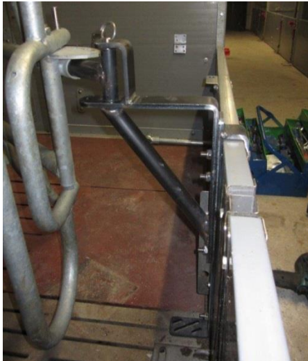
Abbildung 118: Lösungen von Standabstützungen der Trapezbucht, welche über Buchtenwand und Boden außerhalb der Bucht verschraubt sind
