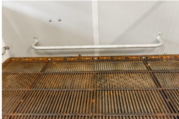
Abbildung 143: SWAP-Bucht: Darstellung der Gussrostelemente und Abdeckungen des "Ferkelklos"
