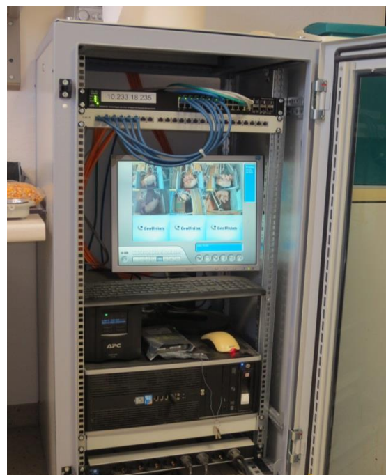
Abbildung 43: Server-Schrank mit Aufzeichnungs-PC
