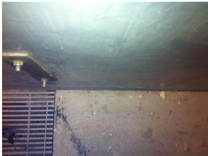
Abbildung 86: Undichte Bereiche zwischen Abteilwand und Gangbereich
