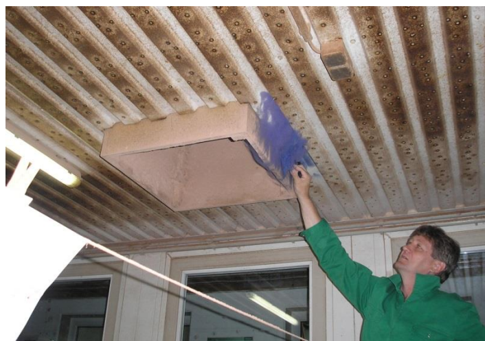
Abbildung 66: Durch den Einsatz von Rauchpatronen werden Luftströmungen sichtbar: der Bereich rund um den Abluftkamin muss abgedichtet werden, da ein Teil der Frischluft ansonsten direkt – ohne den Tieren zur Verfügung zu stehen – wieder abgesaugt wird
