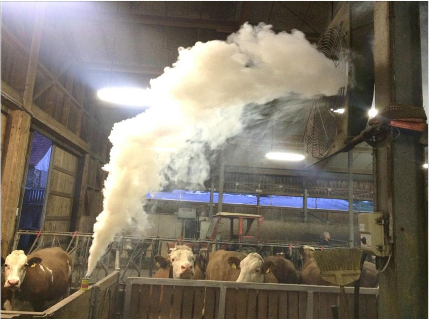
Abb. 5: Kühlwirkung durch Verdunstungskälte (Wind-Chill-Effekt).
