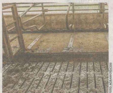
Betonspaltenböden sorgfältig einbauen
