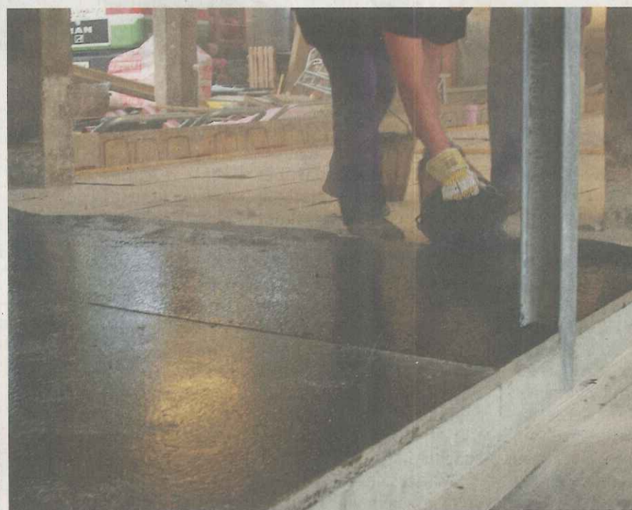
Durch die richtige Rezeptur und Oberflächenbehandlung lässt sich die Abrasivität bei Gussasphalt verringern.
