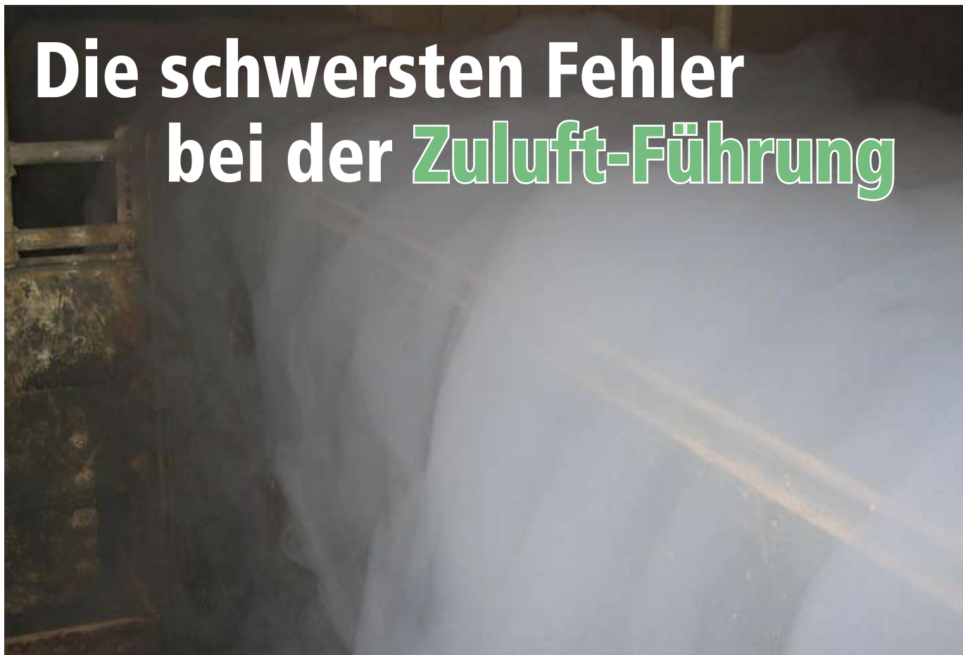
Mit Markierungsrauch werden die Mängel im Lüftungssystem deutlich sichtbar.
