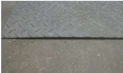
Hier ist die Metallabdeckung über dem Güllebereich undicht.
