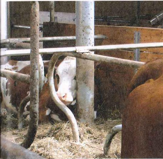
*Die richtige Positionierung von Stützen im Laufstall hat einen wesentlichen Einfluss auf die Eignung von Liegeboxen. Dieser Beitrag zeigt, wo solche Stützen am besten angeordnet und wie sie ausgeführt werden sollen.*
