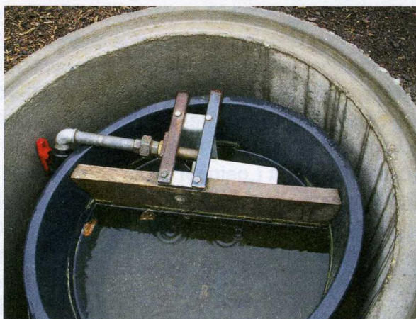
Tröge oder Schwimmerbecken sind kleinen Tränkebecken vorzuziehen
