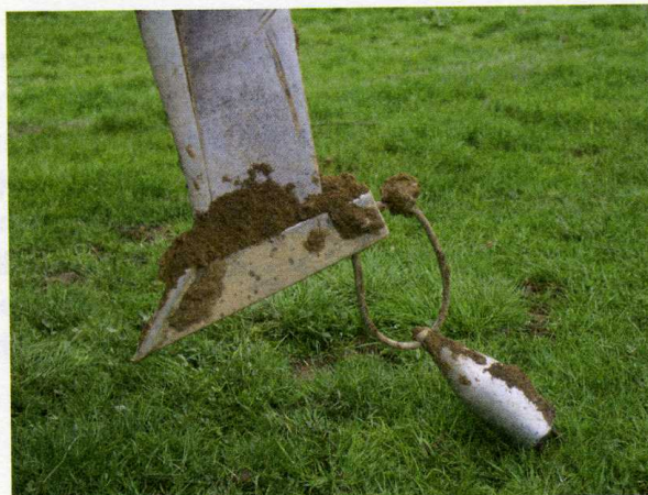
Verlegung einer Wasserleitung mit Hilfe eines Maulwurfspfluges
