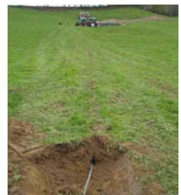
Abb. 5 bis 7: Der Schlauch ist verlegt. Oberflächlich ist kaum etwas zu sehen, die Grasnarbe ist nahezu unverletzt.
