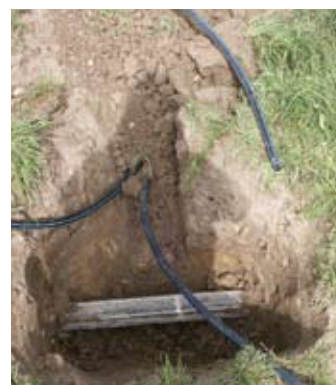
Abb. 5 bis 7: Der Schlauch ist verlegt. Oberflächlich ist kaum etwas zu sehen, die Grasnarbe ist nahezu unverletzt.
