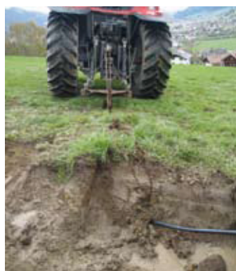
Abb. 5 bis 7: Der Schlauch ist verlegt. Oberflächlich ist kaum etwas zu sehen, die Grasnarbe ist nahezu unverletzt.
