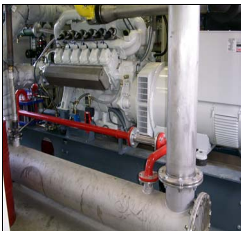
Abb.7: Blockheizkraftwerk
