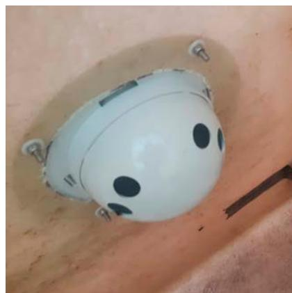
Der Lüfter saugt Außenluft an und verteilt sie über sechs Auslasslöcher im Iglu ohne dabei Zugluft zu erzeugen.
