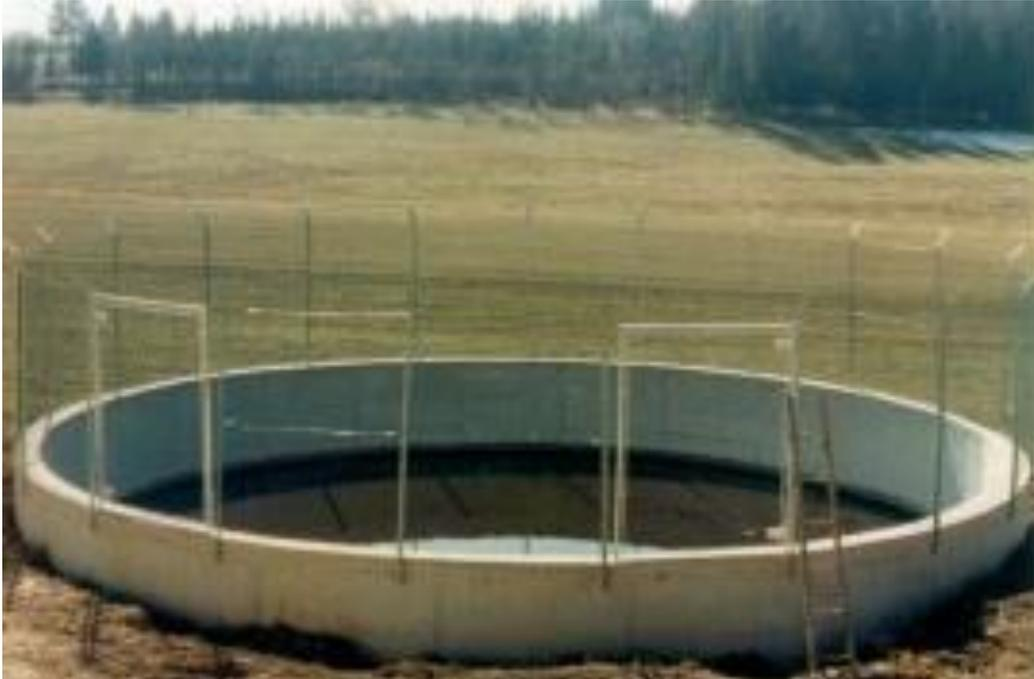
*Abbildung 1:* Güllegrube mit Zaunschutz 11 m Durchmesser, 4 m Höhe
