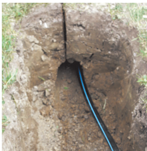
Mit einem Maulwurfspflug lassen sich Wasserleitungen sehr rasch verlegen.
