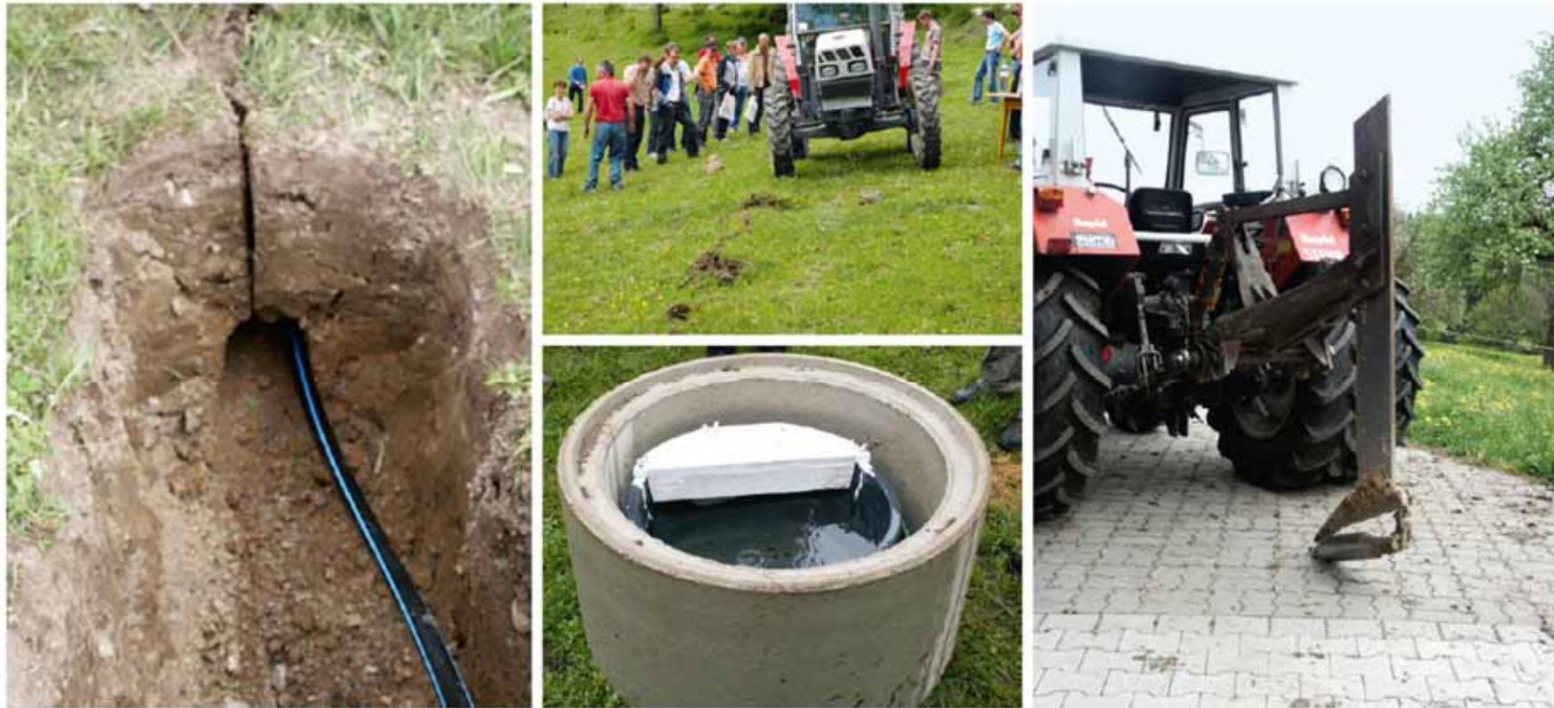
Wasserversorgung – Der Schlauch wird flachgründig mit Hilfe des „Maulwurf-Pflugs“ eingelegt.
