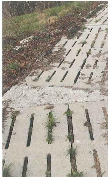
Ausrangierte Spaltenbodenelemente sind eine interessante Möglichkeit, um Wege zu befestigen. Sie dürfen allerdings nicht glatt sein. Lücken, die in Kurven entstehen, werden mit Beton aufgefüllt.
