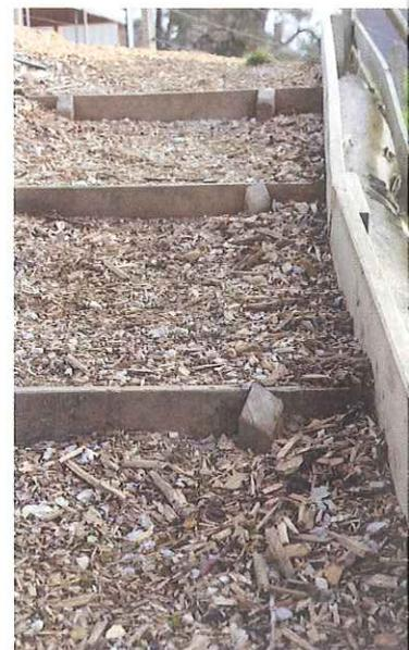
Wenn Geländestufen (über 20 % Steigung) überwunden werden müssen, sind mit Erde oder Holzspänen hinterfüllte Holzschwellentritte zu empfehlen.
