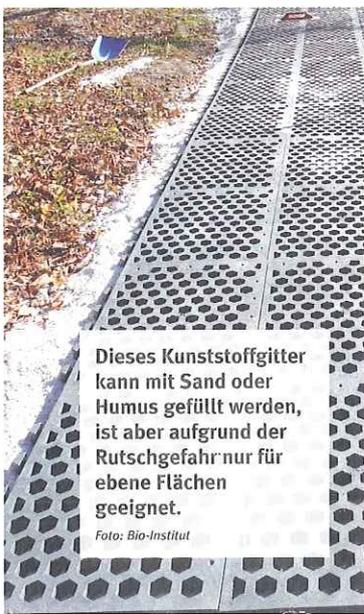
Dieses Kunststoffgitter kann mit Sand oder Humus gefüllt werden, ist aber aufgrund der Rutschgefahr nur für ebene Flächen geeignet.
