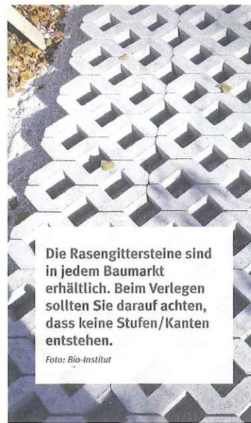
Die Rasengittersteine sind in jedem Baumarkt erhältlich. Beim Verlegen sollten Sie darauf achten, dass keine Stufen/Kanten entstehen.
