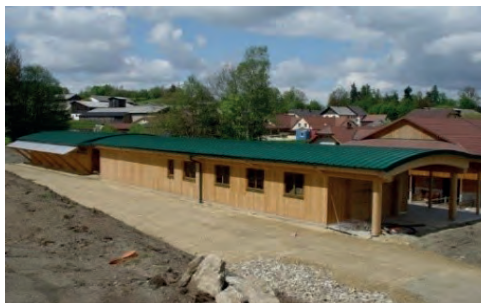
Abbildung 2: Stallgebäude aus CLT (© Holzbau Rast & Ruh GmbH)
