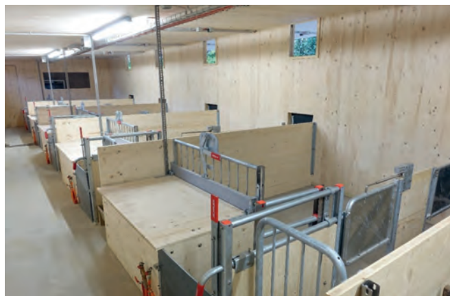
Abbildung 3: Schweinestall aus CLT (Wandstärke 10 cm, 5-lagig; Aufstallung 6 cm, 3-lagig) © Werner Hagmüller
