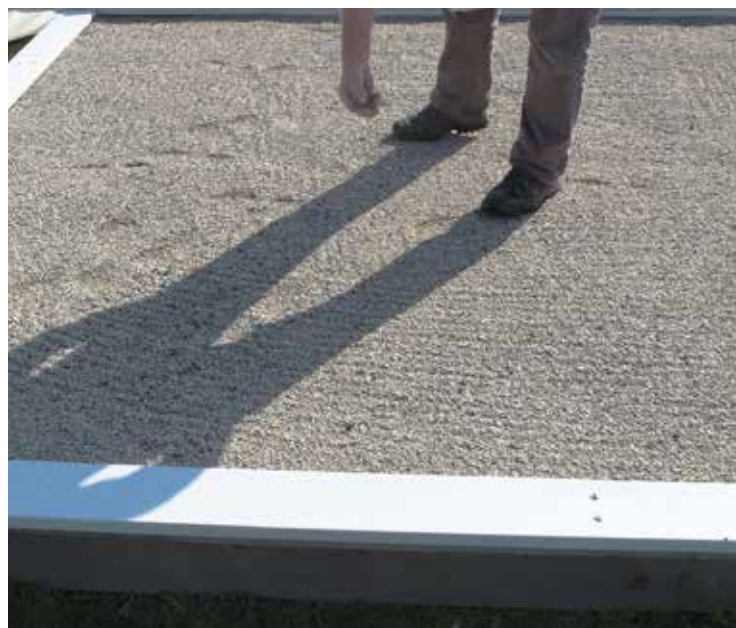
Ansaat des Saatgutes auf der aufgebracht Vegetationstragschicht Foto: W. Graiss
