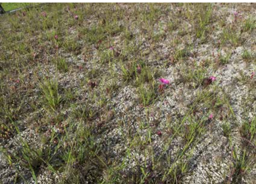
Extensive Dachbegrünung mit Dachsteinkalk mit 10 Masseprozent organischem Anteil Foto: W. Graiss
