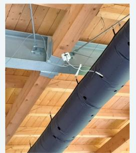
Abb. 3: Strömungsmessung im Schlauch
